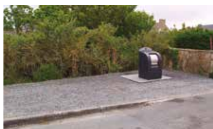
Enfouissement de containers à déchets boulevard de la Banche
