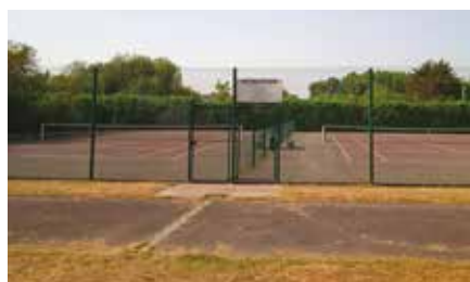
Changement du grillage des cours de tennis
