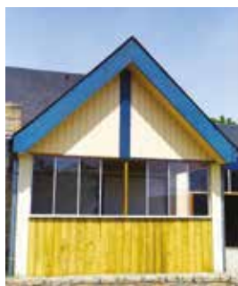
Rénovation du bardage bois du local du Club de boules
