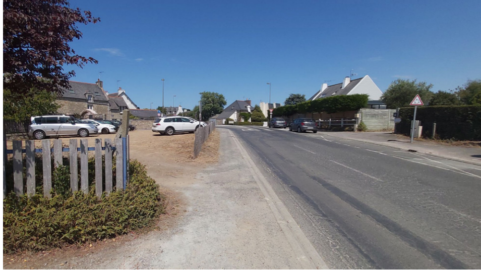
Trottoir dégradé a cause de l'entrée du parking mal utilisé.
