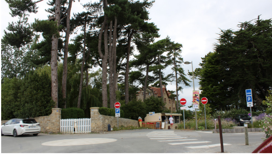
Installation de la signalétique nécessaire, carrefour compliqué
