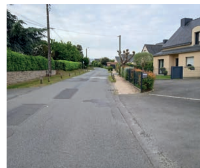
Réhabilitation du trottoir route du Guildo
