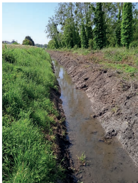
Opération de curage
