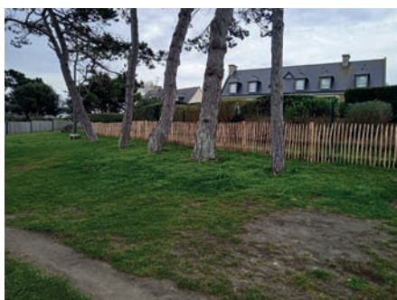
Pose de ganivelles pour délimiter le parking du Rougeret
