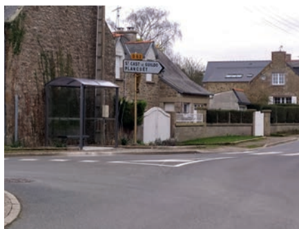
Installation d'un abris-bus scolaire rond- point du Ruet
