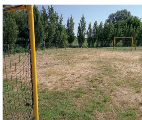
Installation de buts de foot
