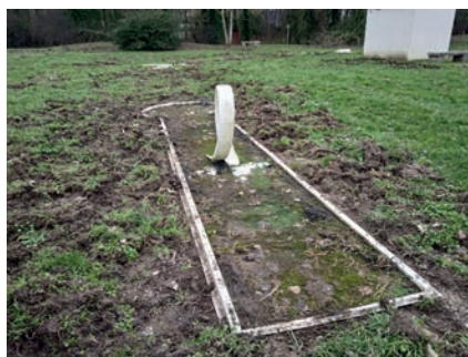
Rénovation du mini golf (avant/après)
