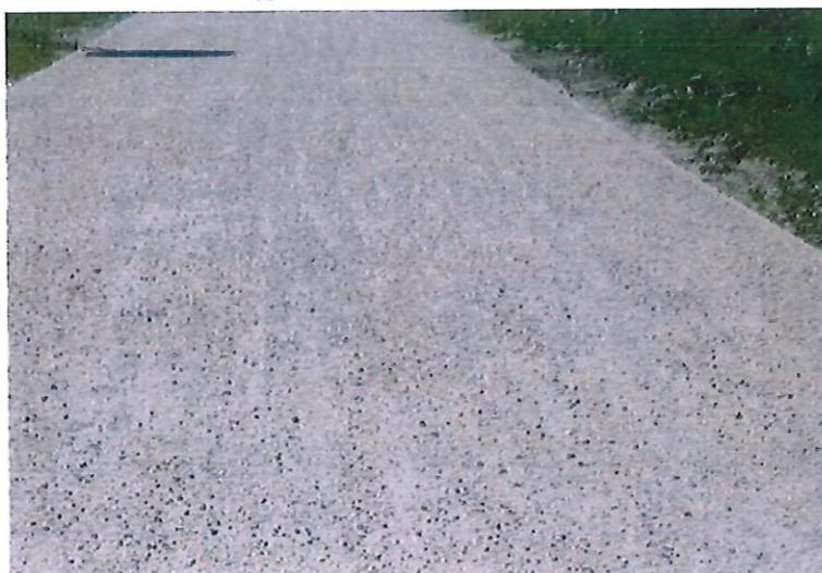
Le cheminement en sable sera coffré avec une simple volige bois. Il ne sera pas utilisé de béton pur la pose de la volige : la volige sera maintenue avec des pieux battus dans le sol existant.
